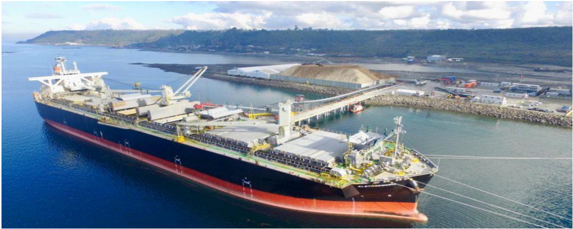
Nave granelera en faenas de embarque , todo es mecanizado.
