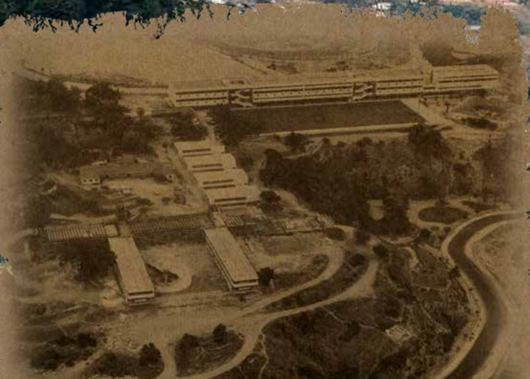
Vista aérea de la Escuela Naval de Punta Arenas A mediados de 1967, estaban construidos el pabellón destinado a alojamiento de los cadetes y brigada de planta, los estudios, dos pabellones de salas de clases y su correspondiente corredor, dependencias que los alumnos comenzaron a ocupar el 5 de julio. Al instalarse en el nuevo local aún permanecían en pie las instalaciones del faro y del fuerte "Valdivia", que se aprecian en el sector de comedores de cadetes y al costado central izquierdo de la fotografía.
