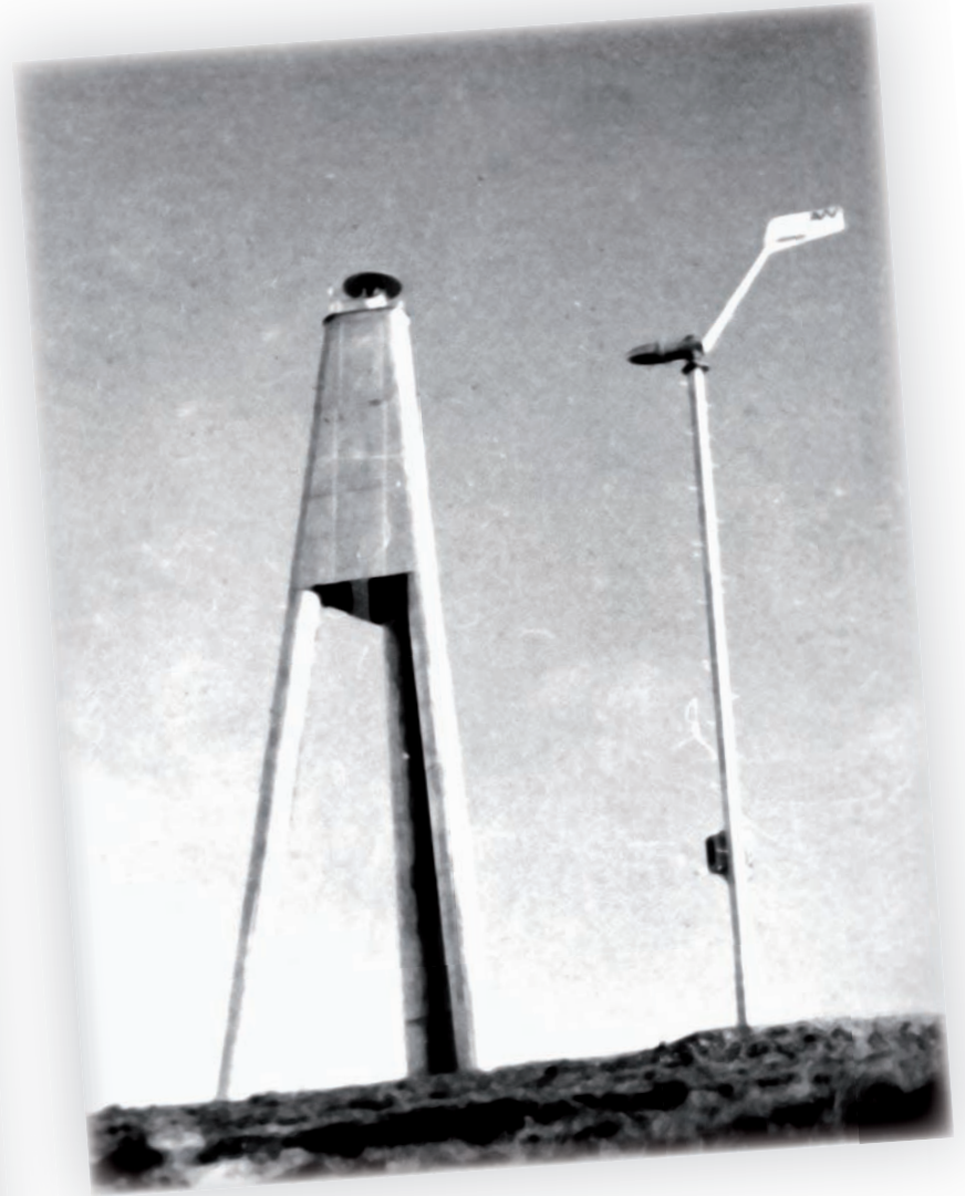
Aerogenerador Cerro Dirección
