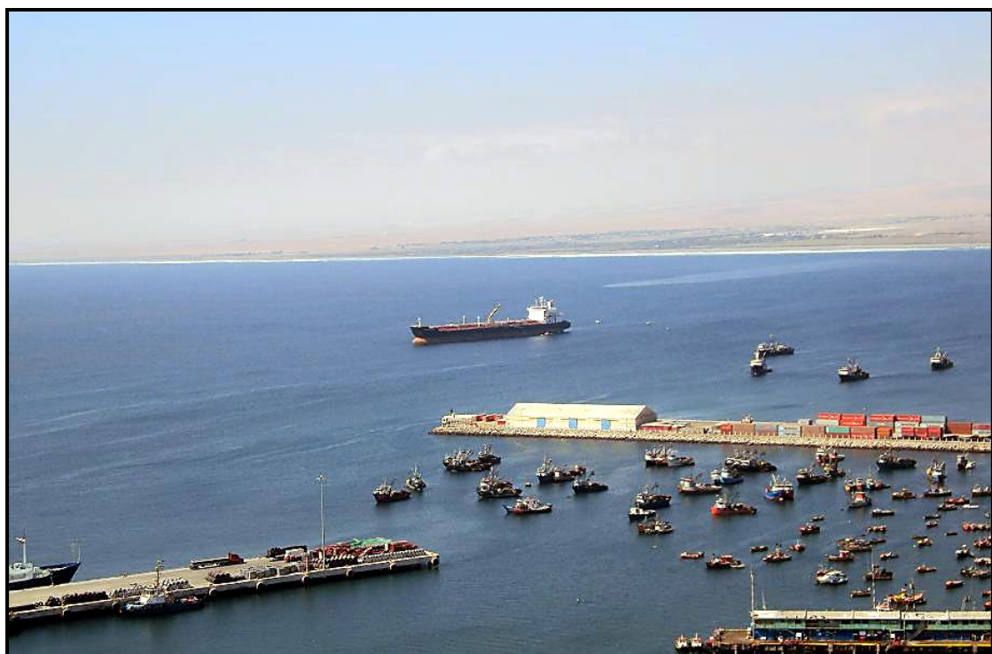
Buque Petrolero amarrado en terminal SICA SICA. Vista desde el Morro
