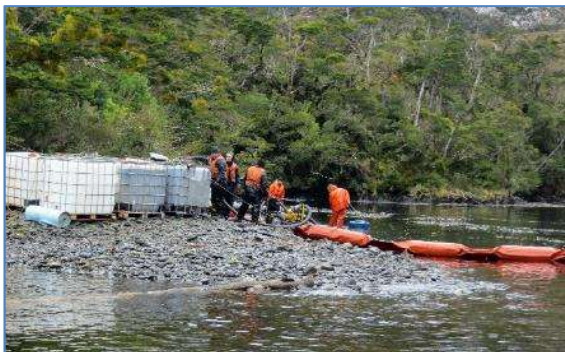
Imagen 33: Recuperación y almacenamiento temporal de residuos de hidrocarburos en bins plásticos.
