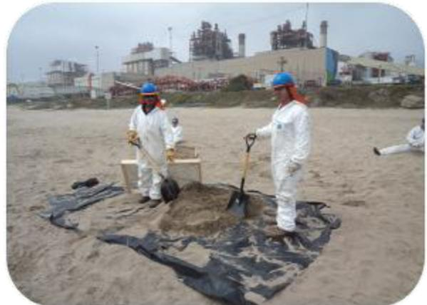
**Imagen 30:** Recuperación de hidrocarburo derramado mediante material absorbente distribuido en la orilla de la costa
