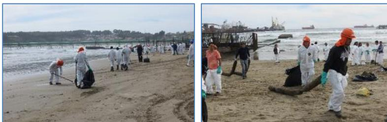
**Imagen 30:** Recuperación de hidrocarburo derramado mediante material absorbente distribuido en la orilla de la costa
