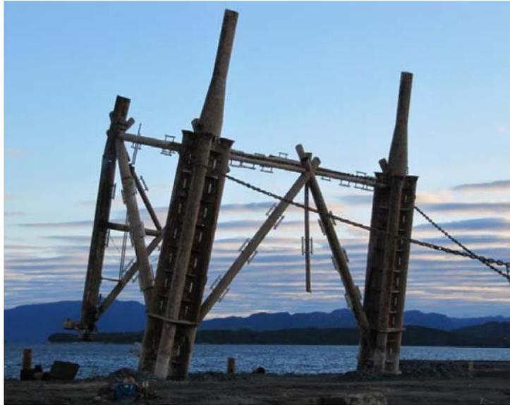
Operación de vuelco de una estructura de acero en una instalación de reciclaje en tierra. Este tipo de construcciones también se pueden hundir en el mar en un lugar adecuado, o volcarse en donde están instaladas si la remoción no es factible. Crédito de la fotografía: AFGruppen, 2011.
